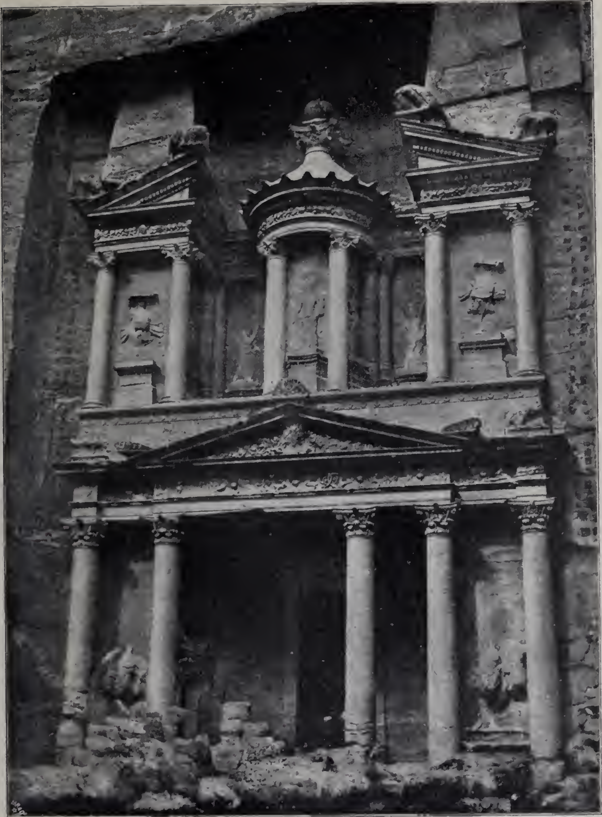
Fig. 227. Grabfassade (Khasnet-Firun) zu Petra. (Nach de Luynes.)
